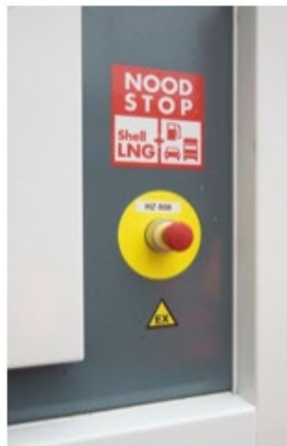
◀ Not-Aus an der Zapfsäule
